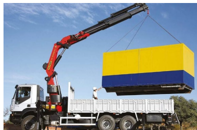
Camion grue (pour la base vie, bennes, contener ...)
